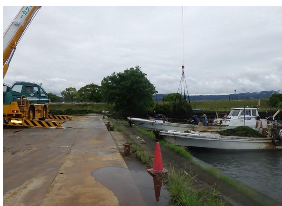
〈根こそぎ除去揚陸作業〉
