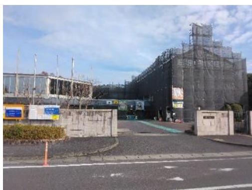
〈外壁工事中の淡海環境プラザ〉
