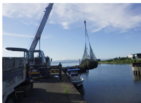
〈表層刈取揚陸運搬作業〉
