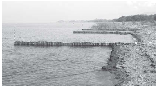
ヨシ帯再生のための浜欠け防止突堤の設置の設置
