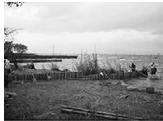
ヨシ帯保護突堤 (工事中)
