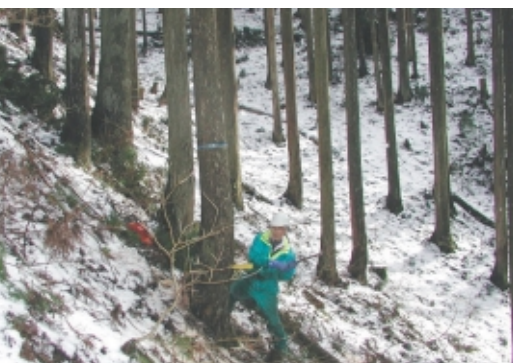
通し柱にするスギの伐採(栗本林業)
