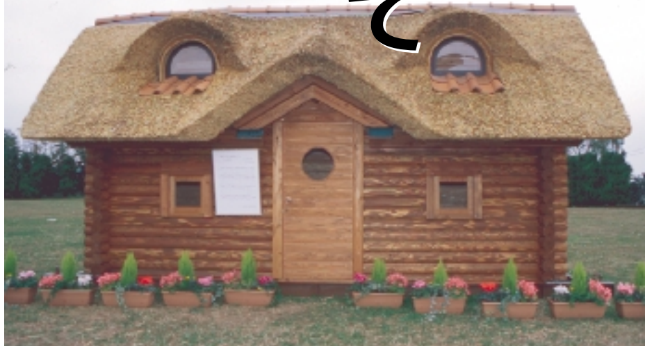
「びわ湖環境ビジネスメッセ2003」に展示されたヨシ葺きのログハウス。オランダのユニークで防火性に富んだニュータイプの屋根を、日本の風土に合うようアレンジした環境こだわり建築になっている（写真上はオランダのヨシ職人による建築作業風景）。
