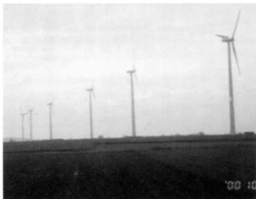
風力発電施設
