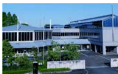
淡海環境プラザ (草津市矢橋町)
