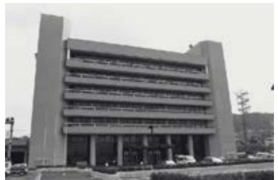
滋賀県大津合同庁舎竣工 (平成4年3月：大津市松本一丁目)
