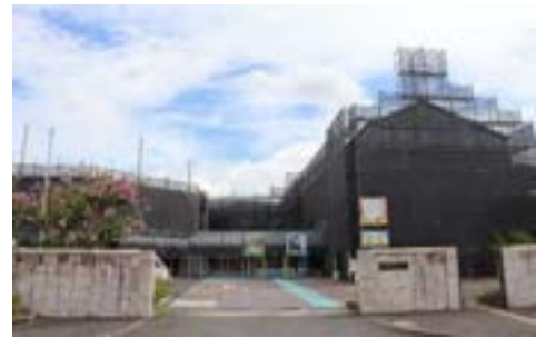
外壁工事中の淡海環境プラザ
