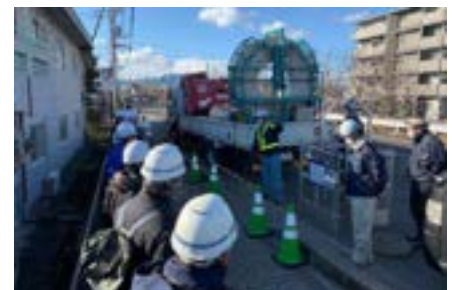
令和3年度 第2回技術講習会 「下水道管渠の更生」
