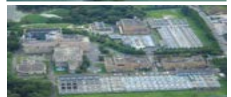
(上) 湖南中部浄化センター (下) 湖西浄化センター
